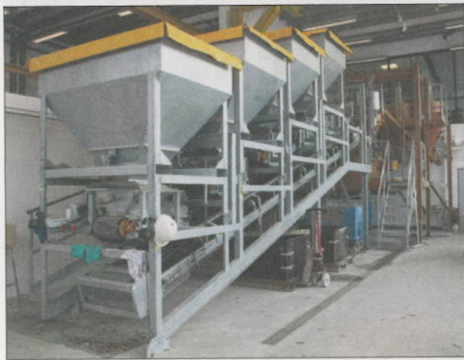
Blandeanlægget i Det Højteknologiske Betonværksted på Teknologisk Institut
